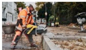
Tecnica di demolizione
