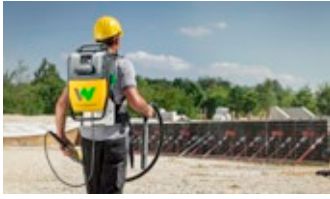
Tecnica di lavorazione del calcestruzzo
