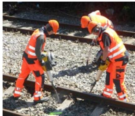
**Los martillos a gasolina BH40 y BH55rw** han sido especialmente optimizados para trabajos de reparación en la construcción de vías férreas.
