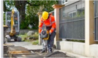
Tehnică de demolare
