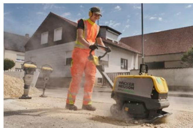
Una sola carica della batteria, consente a APU3050e di compattare fino a 333 m<sup>2</sup> di terreno\*.
