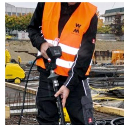
**Práctica empuñadura de mando** para una fácil compactación de piezas prefabricadas planas.
