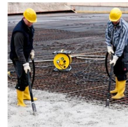
**Fiables y robustos:** los vibradores internos de Wacker Neuson se han convertido en una parte indispensable de muchas obras.
