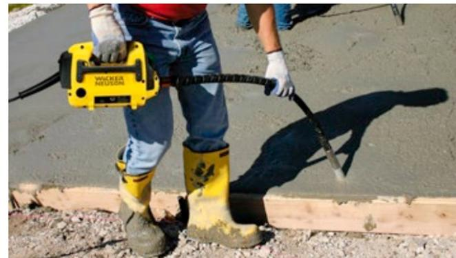
**Solución económica:** con un sistema modular para hormigón compactado de forma óptima con la línea Basic HMS.
