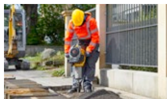
Tecnica di demolizione
