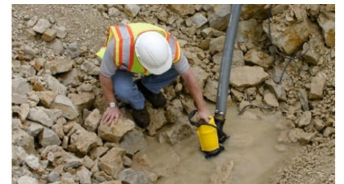
**Trockenlaufsichere Elektrotauchpumpen:** auch bei langem Schürfbetrieb dank integriertem Ölverteiler.
