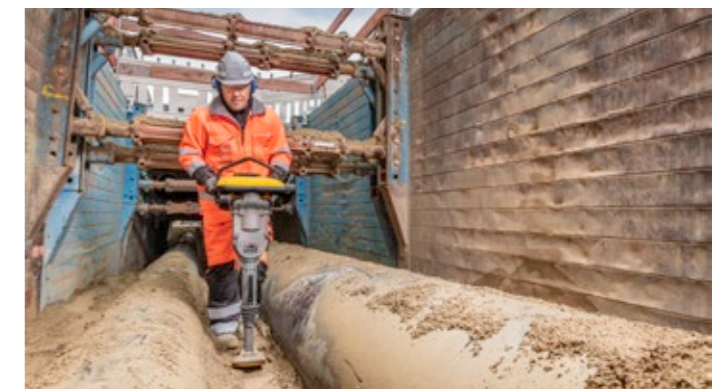
BS30 – Der Spezialist für schmale Gräben und Rohrzwickelverdichtung.
