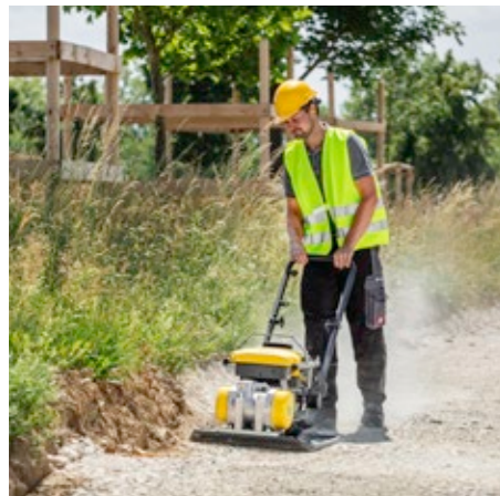
Mit ihrer hohen Geschwindigkeit und der breiten Grundplatte ist die AP2560e ideal für zum Einrütteln von großen Pflasterflächen geeignet.
