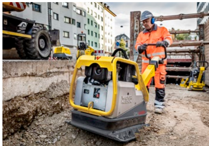
In jedem Fall sicher: Wird der Führungsbügel losgelassen, bewegt sich das Gerät nur noch auf der Stelle.
