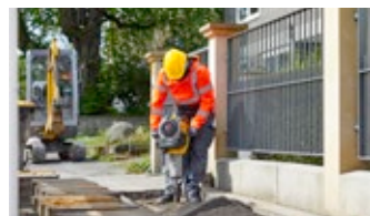
Technique de démolition
