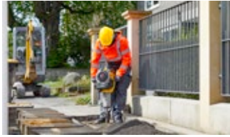
Tecnica di demolizione
