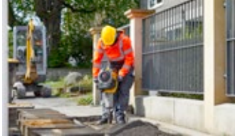
Tecnología de demolición y corte
