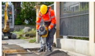
Cięcie i wyburzanie
