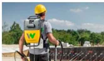
Technika na úpravu betonu
