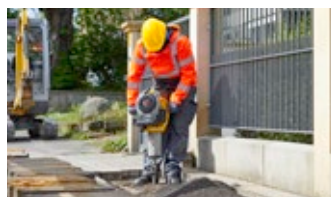
Cięcie i wyburzanie
