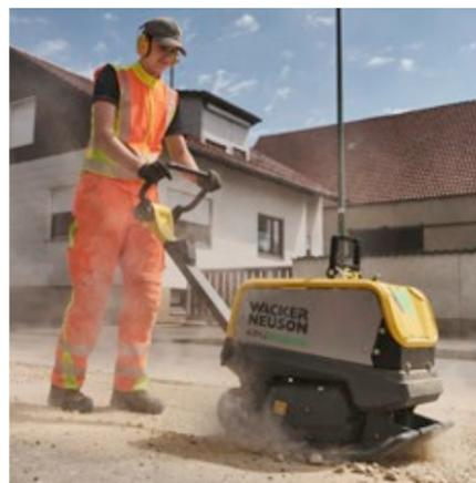
Mit einer Batterieladung verdichtet die APU3050e bis zu 333 m<sup>2</sup> Boden\*.
