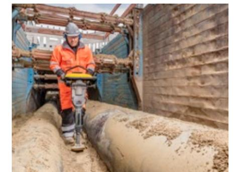
**BS30** – Der Spezialist für schmale Gräben und Rohrzwickelverdichtung.
