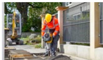
Cięcie i wyburzanie
