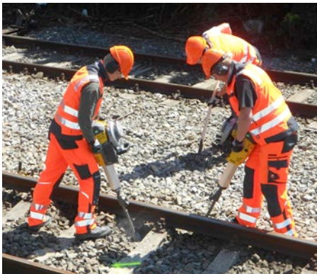
De benzinebreekhamers BH40 en BH55rw: zijn speciaal geoptimaliseerd voor onderhoudswerkzaamheden in de spoorbouw.
