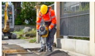
Cięcie i wyburzanie
