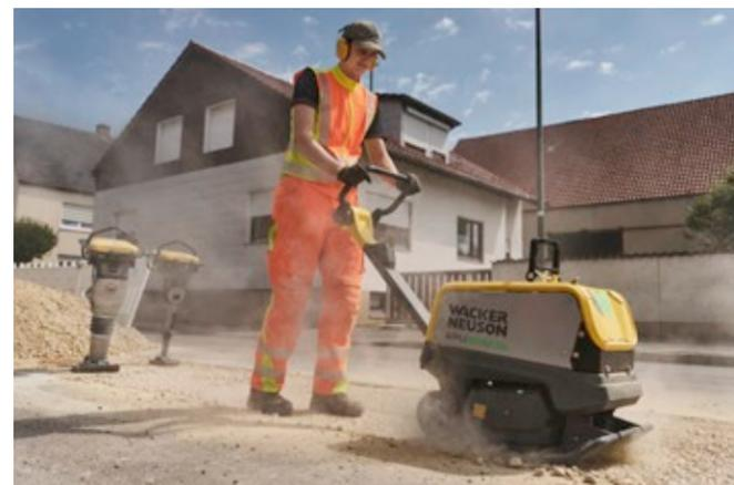
Con una carga de la batería, la APU3050e compacta hasta 333 m<sup>2</sup> de suelo\*.
