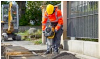
Tecnica di demolizione
