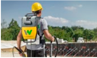
Tecnologia del calcestruzzo
