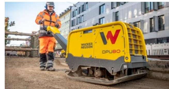
Alto rendimiento para trabajos de compactación exigentes en la construcción de carreteras.
