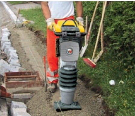
Nauwkeurige apparaatsturing – belangrijk bij de verdichting langs randen.
