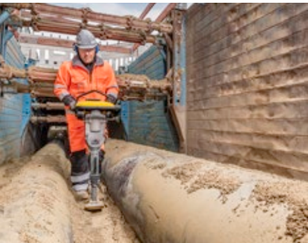
BS30 – De specialist in smalle greppels en verdichting bij het leggen van pijpen.
