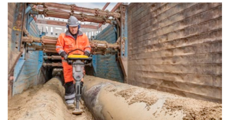
BS30 – Eksperten i smalle udgravninger og rørendekomprimering.
