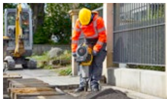
Cięcie i wyburzanie
