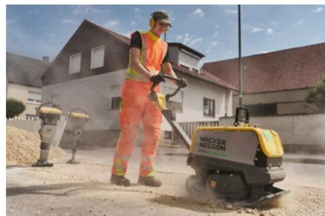
Avec une charge de batterie, l'APU3050e peut compacter jusqu'à 333 m<sup>2</sup> de sol\*.
