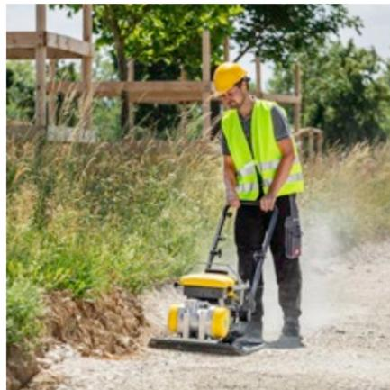
Grâce à sa vitesse élevée et à sa large plaque de base, l'AP2560e est idéale pour la mise en place de grandes surfaces de pavés autobloquants.
