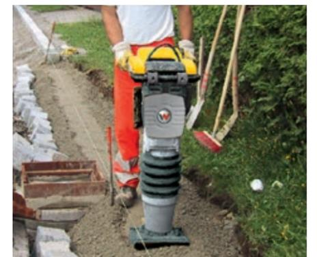
**Guidage précis de l'appareil** – une caractéristique essentielle pour les travaux de compactage en bordure.
